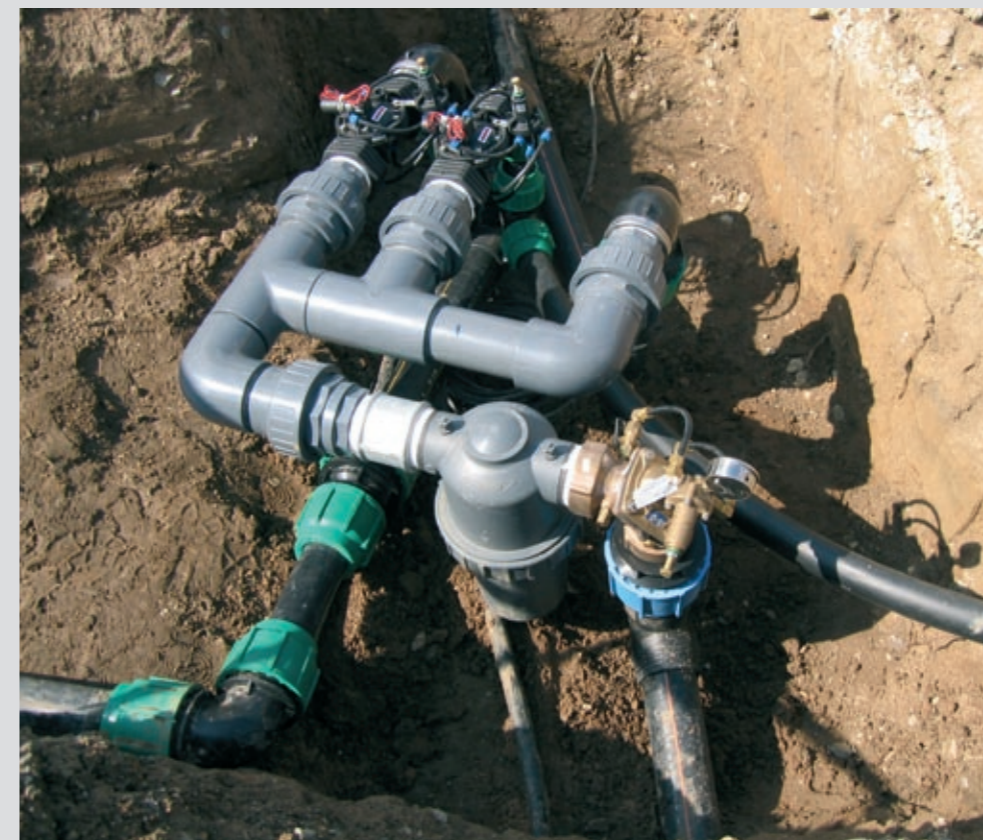
Versorgung der einzelnen Bewässerungsstränge erfolgt über Feldkopfstationen.
