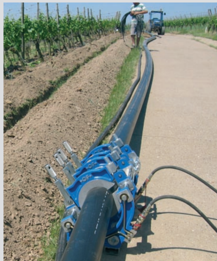
Stumpfschweißung der PE 100-Zuleitung mit einer GF 250-Stumpfschweißmaschine
